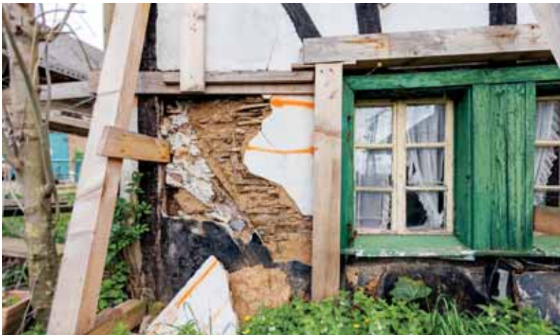
▲ Sprossenfenster mit grünen Läden inmitten des zerstörten Mühlenhaus-Fachwerks. Seit der Flut von 2021 werden sie von einer Notsicherung fixiert.
